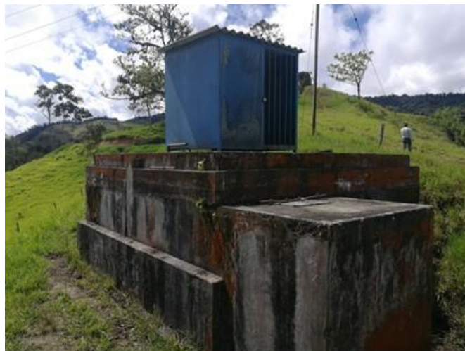
TANQUE DE ALMACENAMIENTO Y CASETA DE CLORACIÓN
