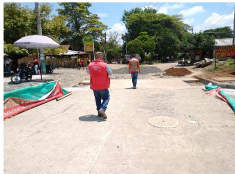
Las fotos muestran un pavimento inconcluso pero lo ejecutado muestra una excelente calidad. Se pudo comprobar que la resistencia a la compresión de este pavimento rígido, es de 4000 P:S:I.
