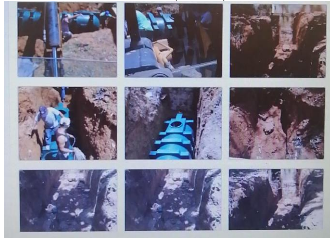
Instalación de pozo séptico
