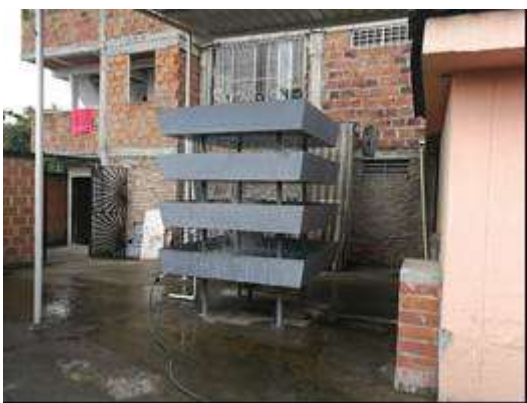
Pozo Profundo – Sistema de Aireación
