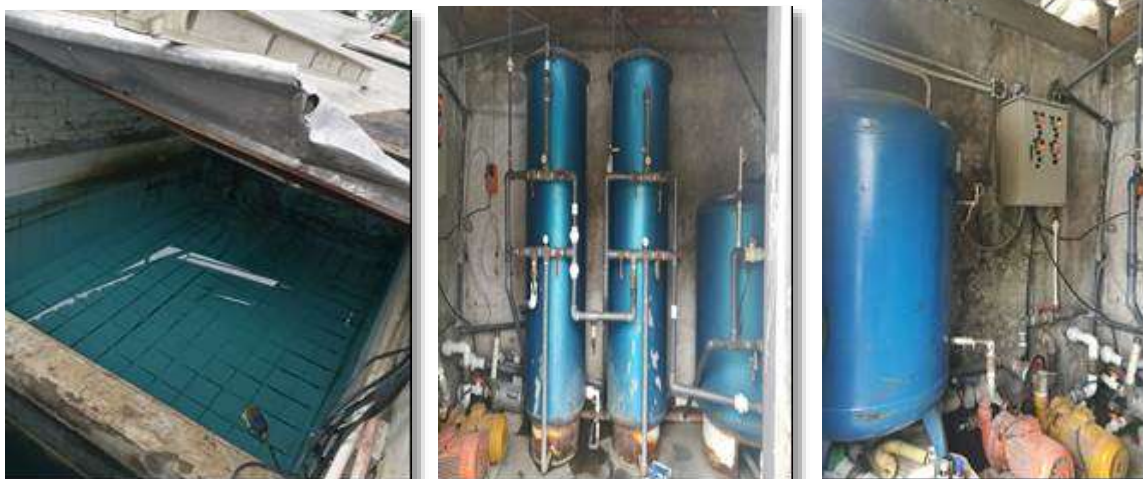
Tanque de Almacenamiento – Filtros – Sistema de bombeo
